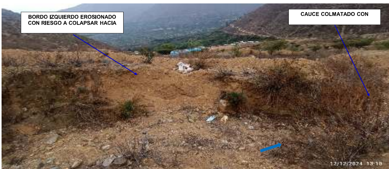
FIGURA N°02: CAUCE COLMATADO CON FLUJO DE DETRITOS, EN LA MARGEN DERECHA INGRESA SEDIMENTOS A CAUSA DE PRECIPITACIONES PLUVIALES; BORDO DE LA MARGEN IZQUIERDA SE ENCUENTRA EN POLIGRO DE SER EROSIONADO CON RIESGO HACIA C.P. DE CUCAPUNCO.
