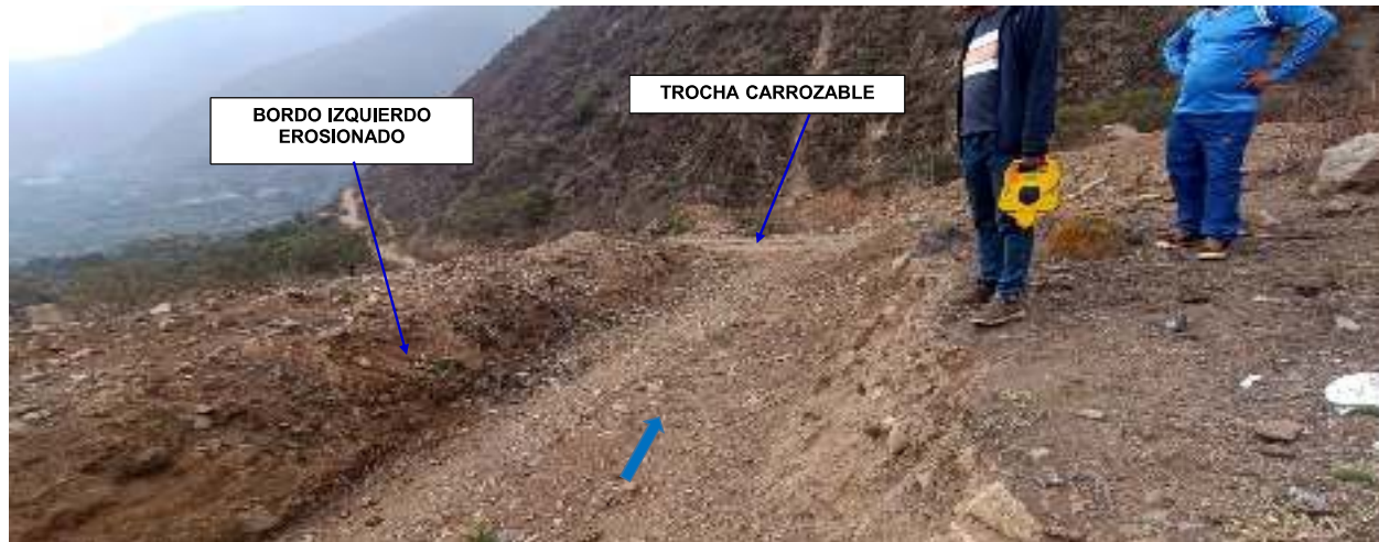
FIGURA N°03: TRAMO FINAL DE LA QUEBRADA CUCAPUNCO QUE SE ENCUENTRA COLMATADO QUE REQUIERE SER DESCOLMATADO Y CONFORMAR UN DIQUE EN LA MARGEN IZQUIERDA.
